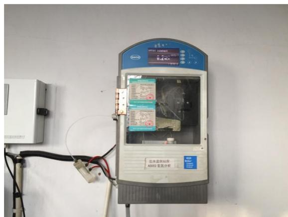
图 3-2 氨氮在线监测装置
