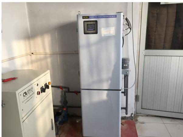
图 3-3 总磷、总氮在线监测设施图
